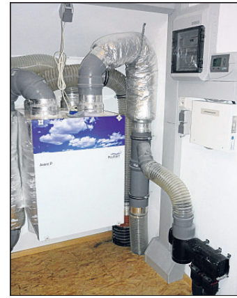
Die Komfort-Be- und Entlüftung bietet übers ganze Jahr einen geregelten Luftwechsel.
